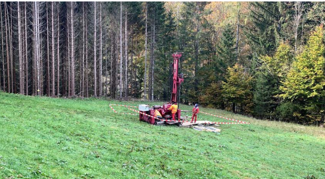
Kernbohrung zur Erhebung geologischer Daten im Projektgebiet (Foto: APG).
